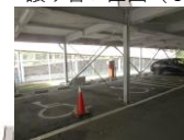
第3駐車場 譲り合い区画（3台）
